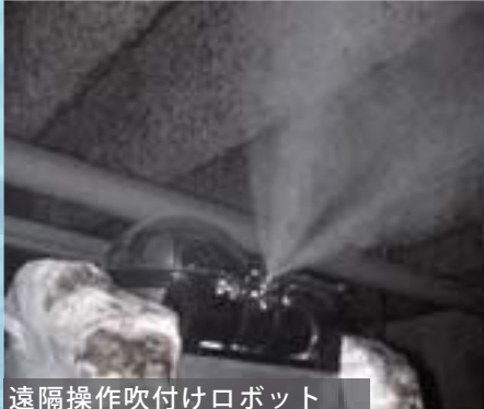
対煙突リール昇降式吹付けシステム
